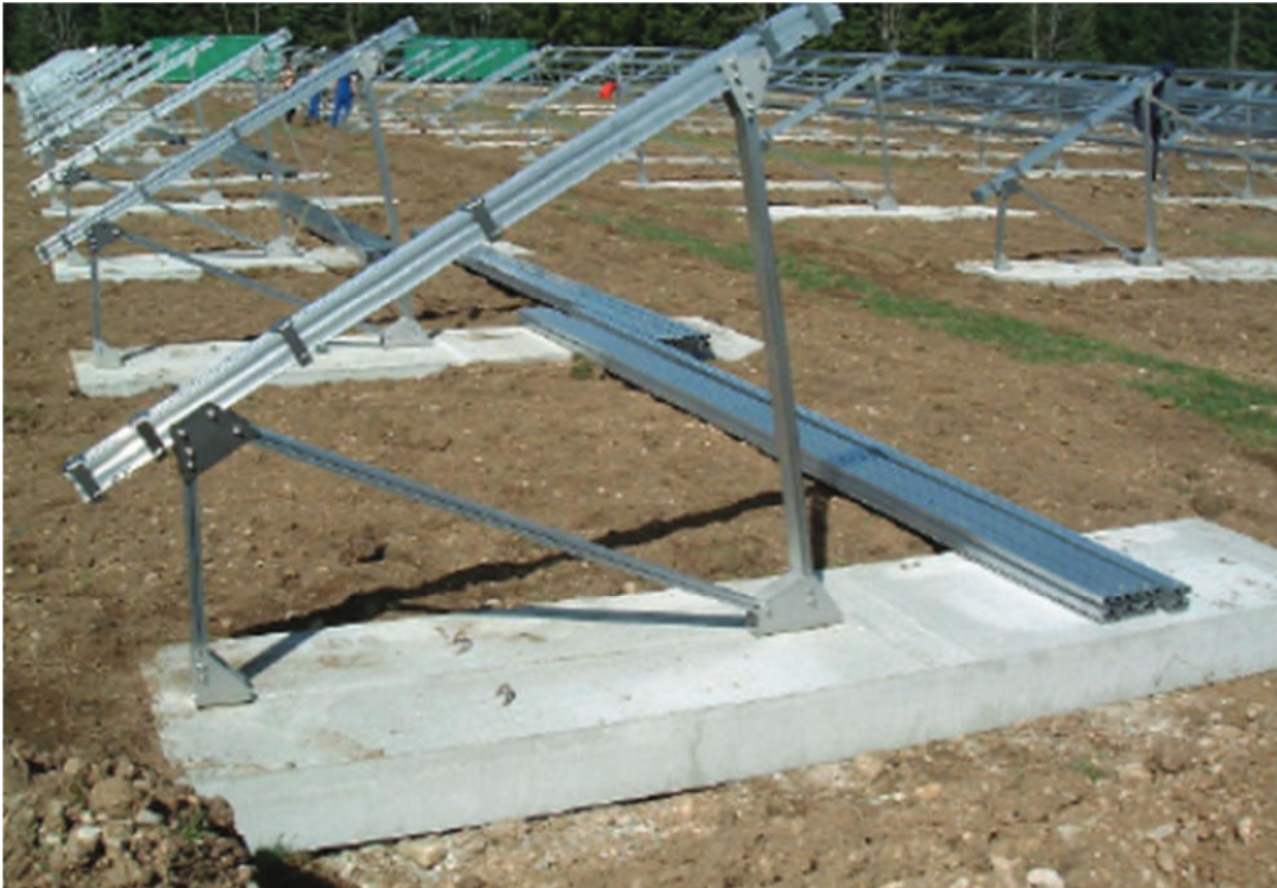
Abbildung 3: Aufgesetzte Betonfundamente 3
